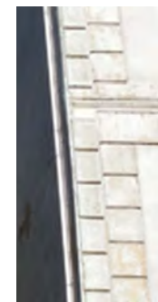
Exemples de chaînages d'angle conservés.
