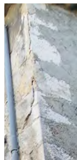
Exemples de chaînages d'angle conservés.
