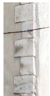
Exemples de chaînages d'angle conservés.
